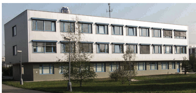
Obr. 5: Budova ČMI OI Praha po rekonstrukci
