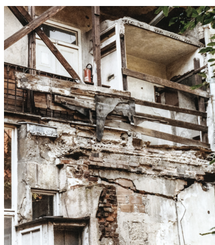
Obr. 3: Stav budovy na Betlémském náměstí, druhé působiště oblastního inspektorátu ČMI v Praze
